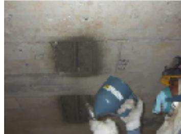
α防錆ペーストの塗布完了(塩害対策工法)
